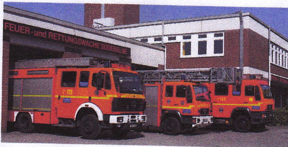
Die Feuer- und Rettungswache Hamburg-Süderelbe, der schon ein Schicksal als Lagerstätte und reine Rettungswache bestimmt war, bleibt erhalten.
